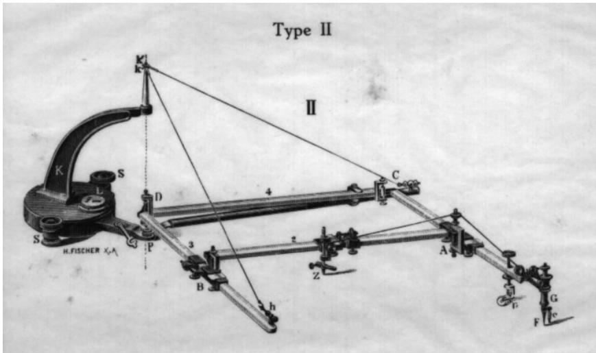
Abb. 87: Pantograph Typ II von OTT & CORADI [38]
